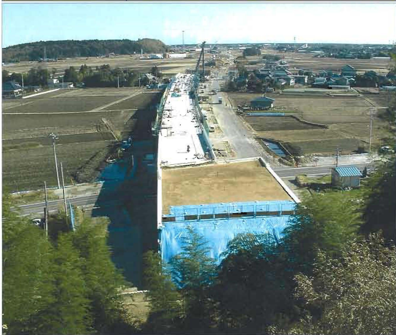
平成17年度中の完成を目指して急ピッチで工事が進む銚子連絡道路「松尾町～光町間」
