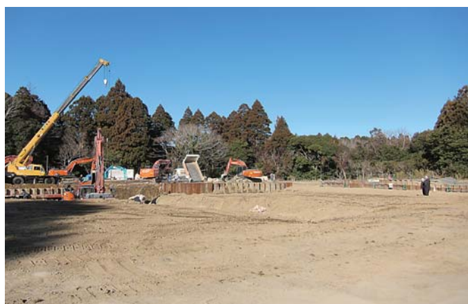
▲解体撤去工事の状況
