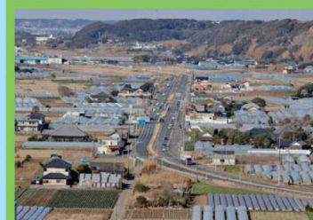
飯岡バイパス 供用中
