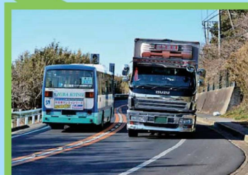
八木拡幅 事業中 ※現道部分
